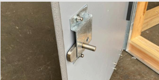
Als Verschluss der Türe sind oben und unten Fallenriegel angebracht, welche von Innen und Außen betätigt werden können.
